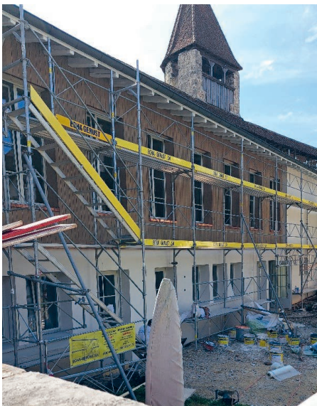
Die Holzfassade ist fertig
