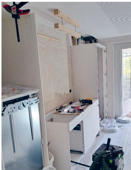
Vorbereitung der Wände und Decken
