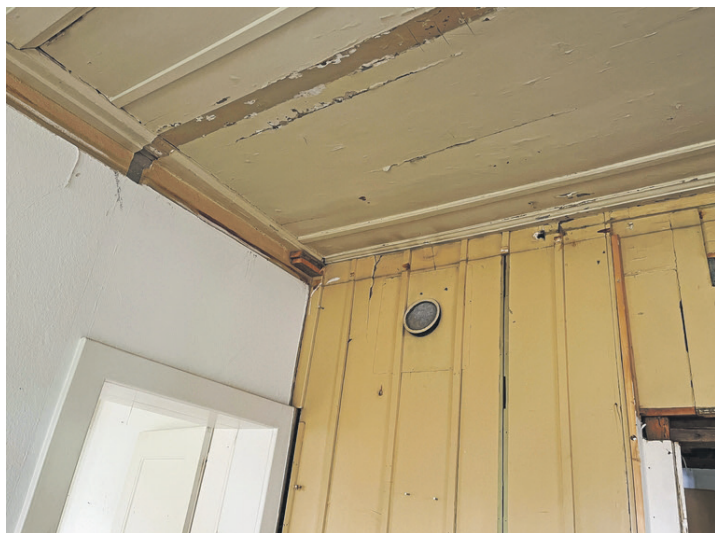
Das Entfernen der Verkleidung hat alte Baustrukturen zutage gebracht.
